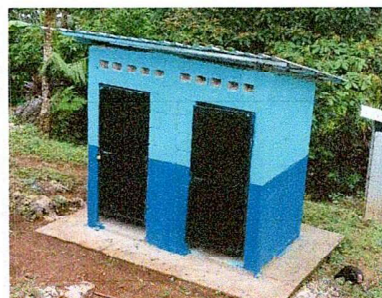
Foto 2: Sanitarios rehabilitados para beneficiar a 126 alumnos.
