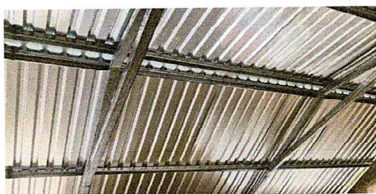
Foto 5: Estructura nueva de aulas remozadas.
