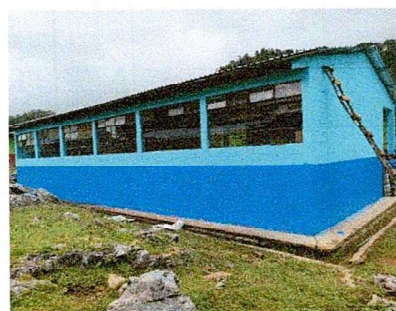
Foto 4: Fachada posterior de aulas remozadas.
