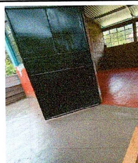
Foto 6: Puertas nuevas para aulas remozadas.
