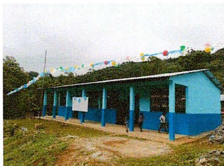
Foto1: Panorámica de las aulas rehabilitadas.
